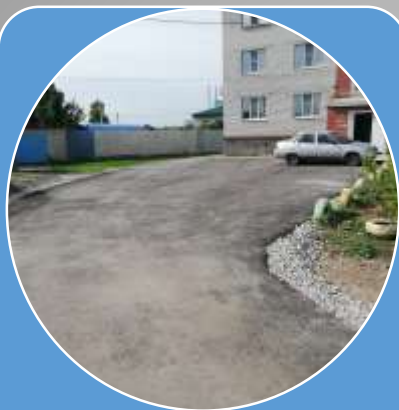
Ул. Заводская д.7
