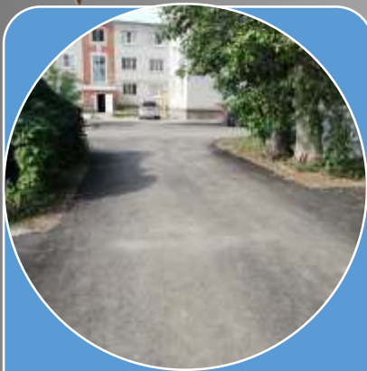
Ул. Заводская д. 5
